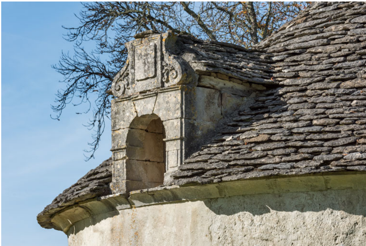
Détail de la lucarne sud.
