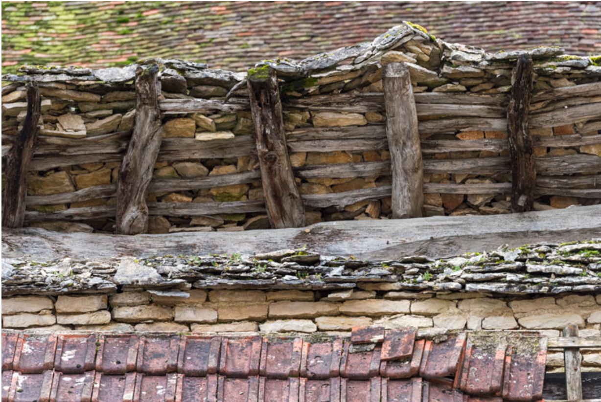
Détail de la toiture côté est.
