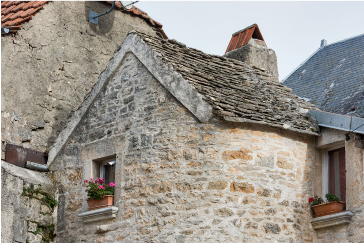
Détail de la toiture côté nord-ouest.
