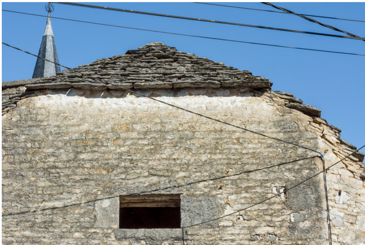
Détail de la toiture côté sud.
