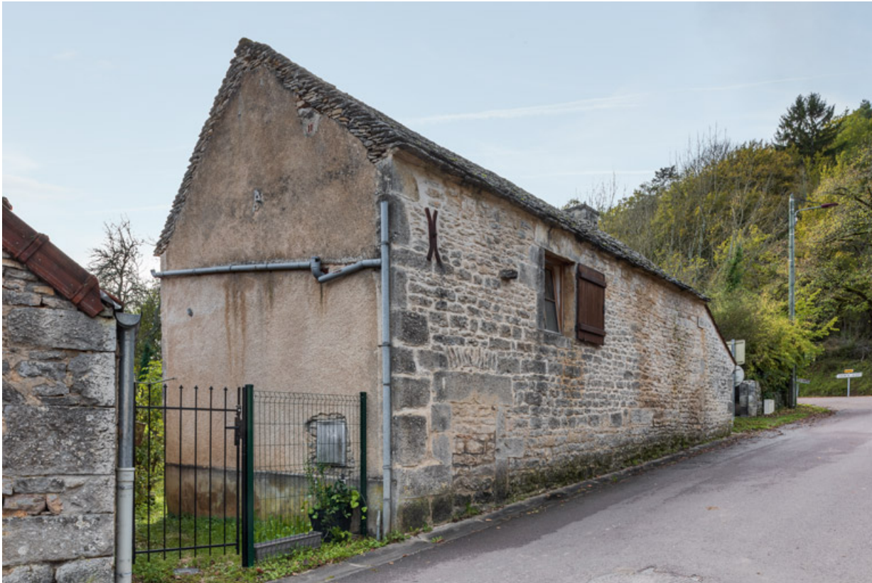
Détail du mur pignon est.
