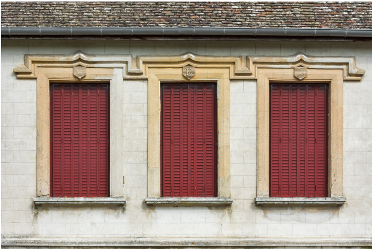
Elévation latérale gauche : baies de l'étage.
