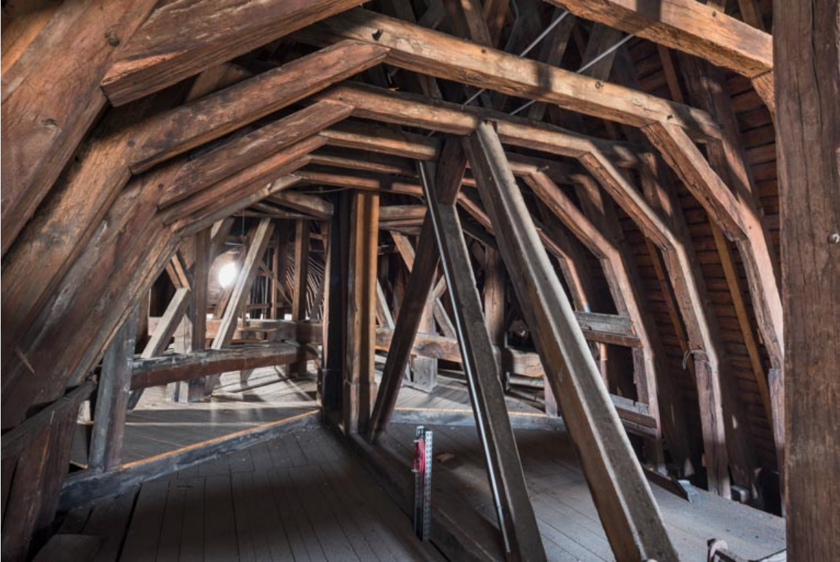
Comble : vue prise depuis le chevet oriental.
