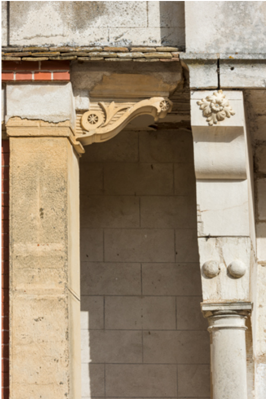
Galerie : supports côté cour.
