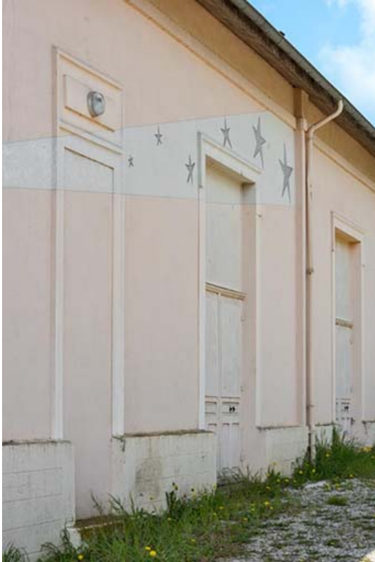
Façade antérieure : décor peint, vu en enfilade.
