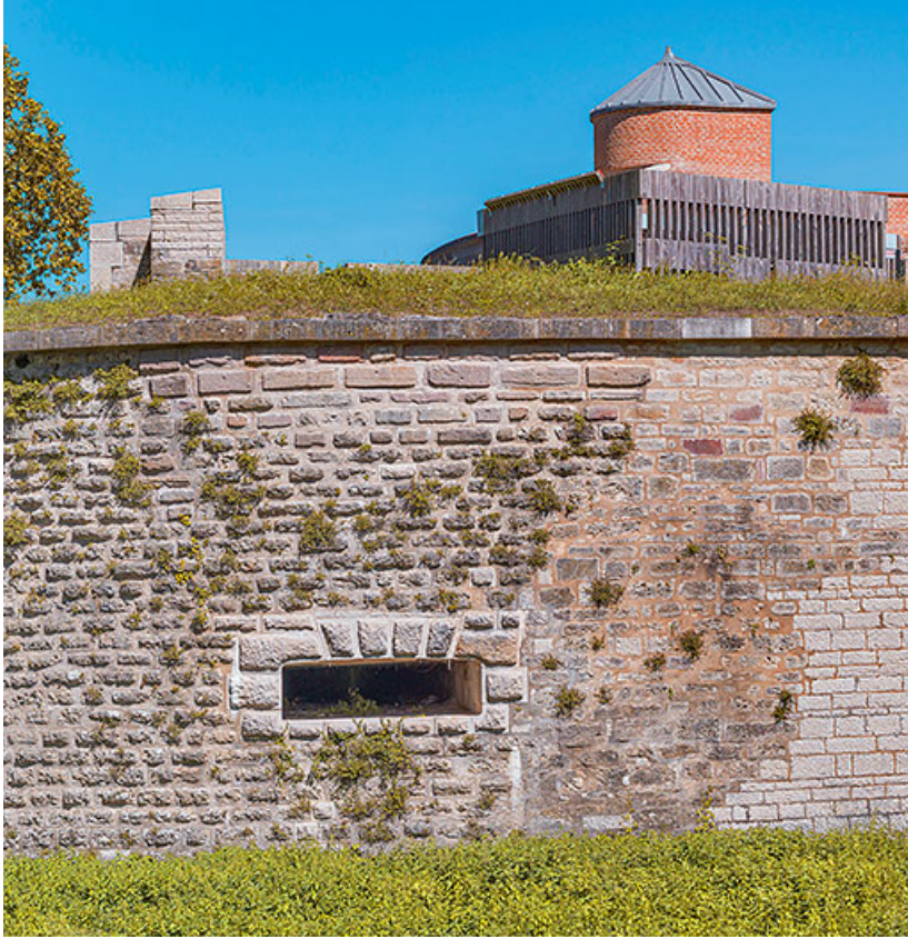
La tour basse des moulins du château.
