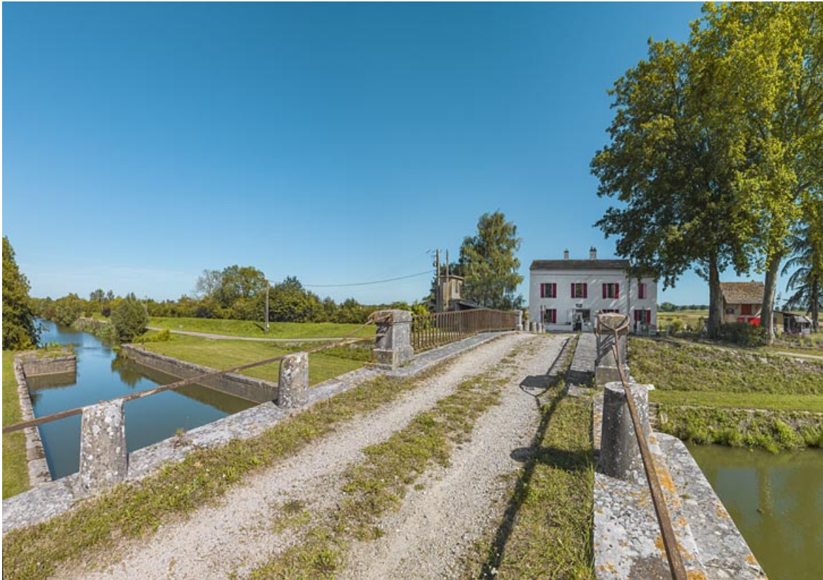
Le pont vu du dessus.
