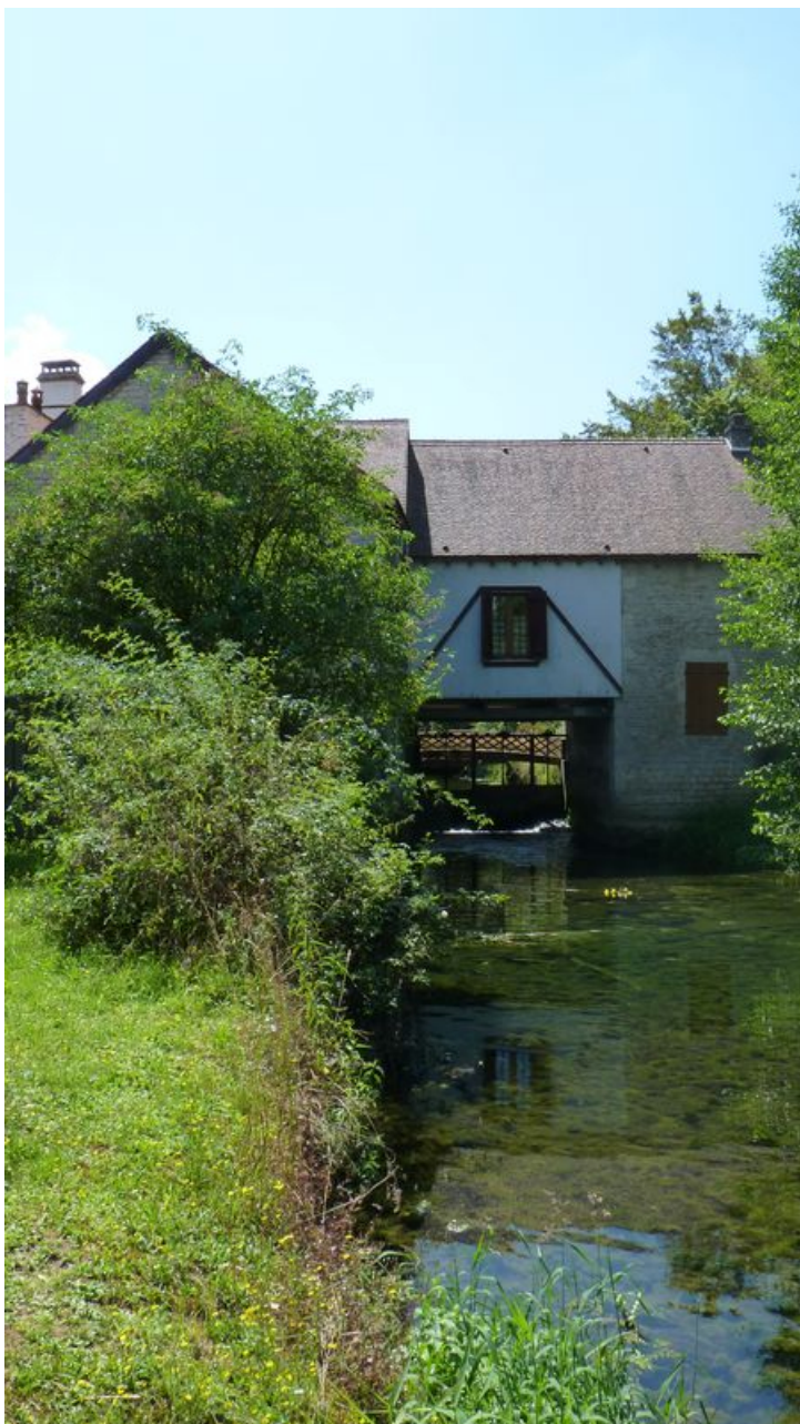
Vue du moulin depuis l'ouest.
