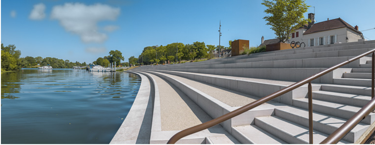
Vue d'ensemble des quais après leur réaménagement.
