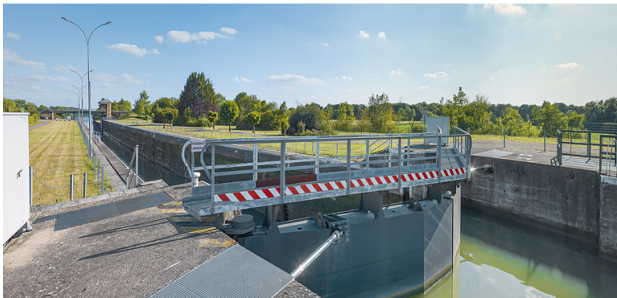
Vue d'ensemble des portes amont de l'écluse.
