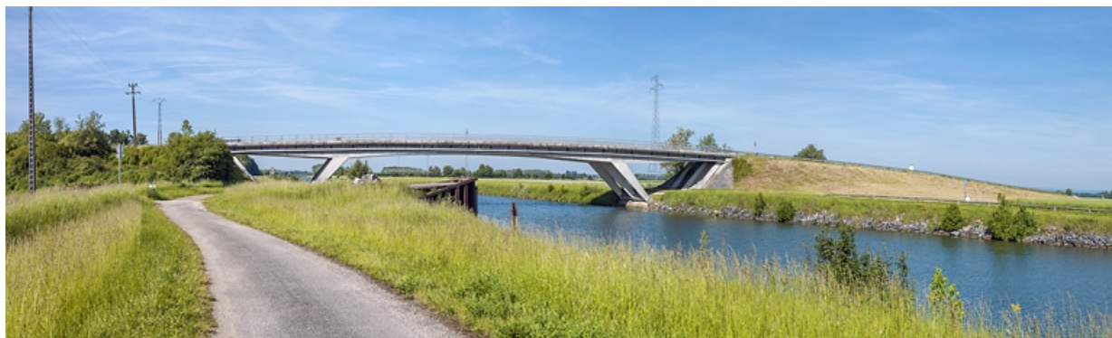
Vue d'ensemble d'amont, rive gauche.
