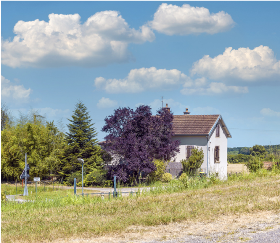
La maison éclusière de Poncey.
