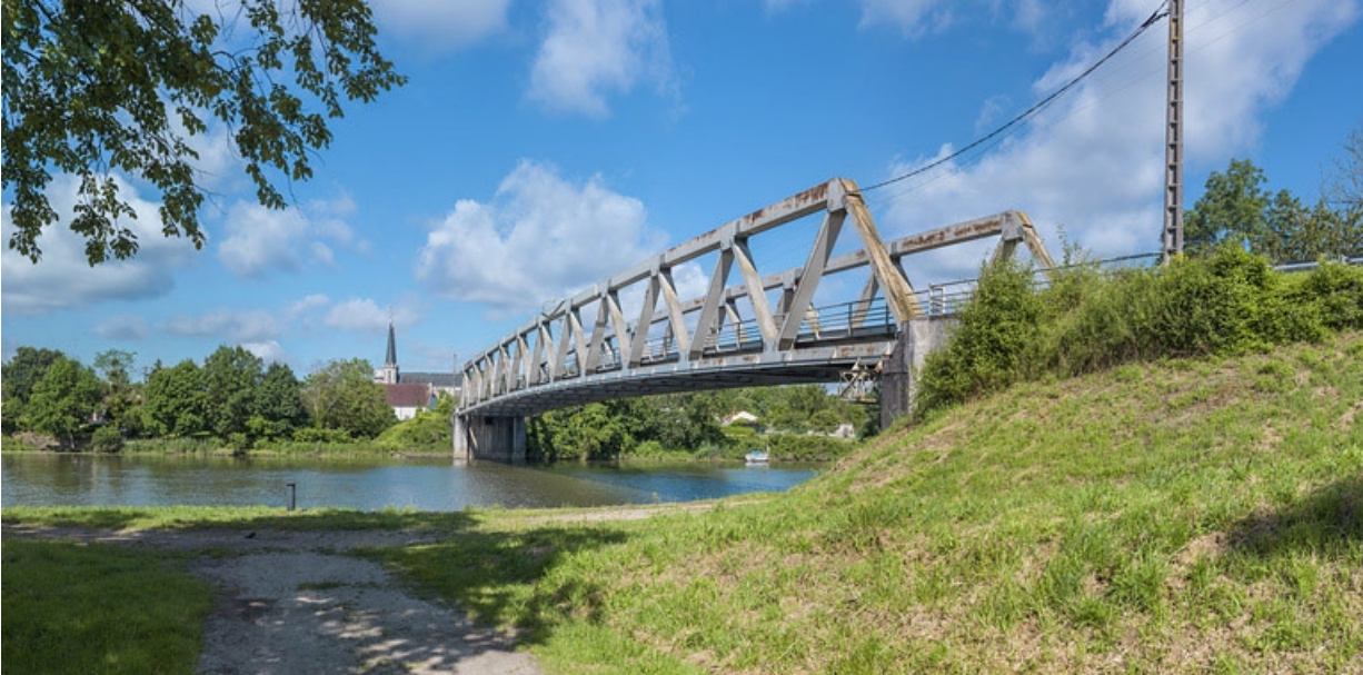
Pont routier de Lamarche-sur-Saône (21).
