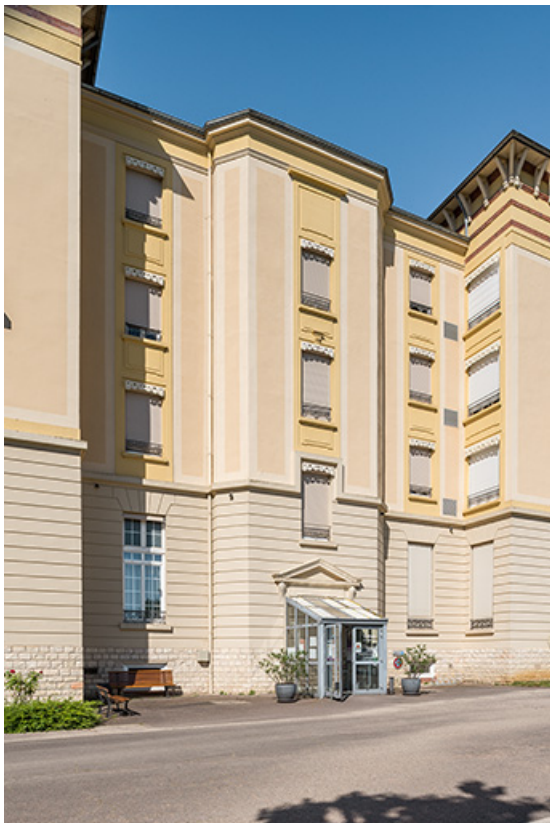
Façade nord-est avec l'entrée de l'escalier.
