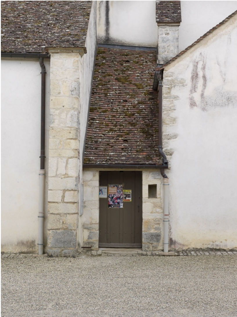
Porte latérale nord : porte et sas d'entrée.
