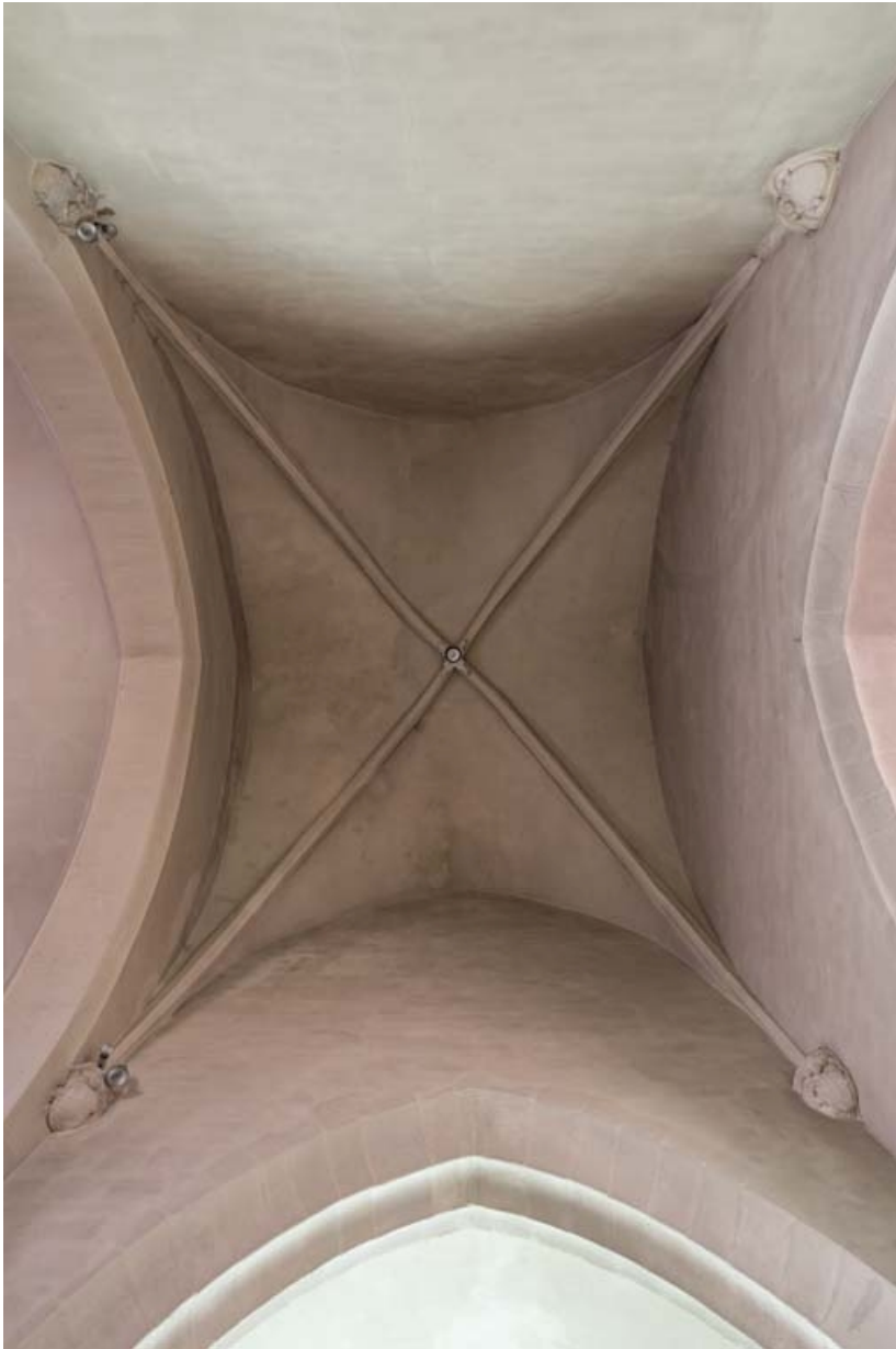
Voûte de la croisée du transept.
