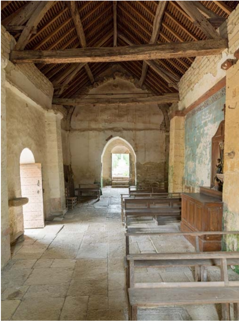
La nef, vue depuis le chœur.
