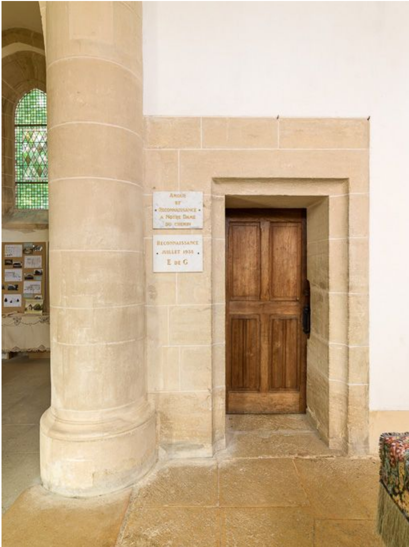
Vue de la porte de la sacristie.
