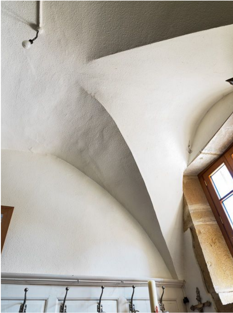
Voûte de la sacristie.
