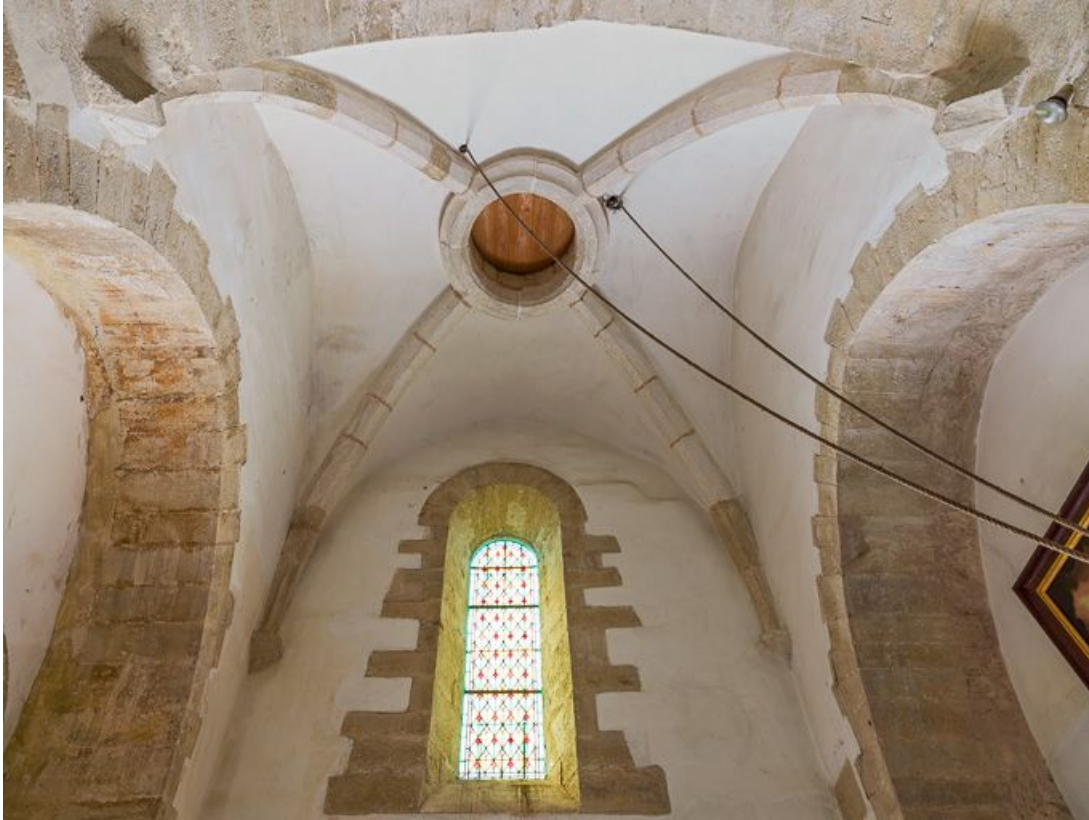
Voûte de la travée sous clocher.
