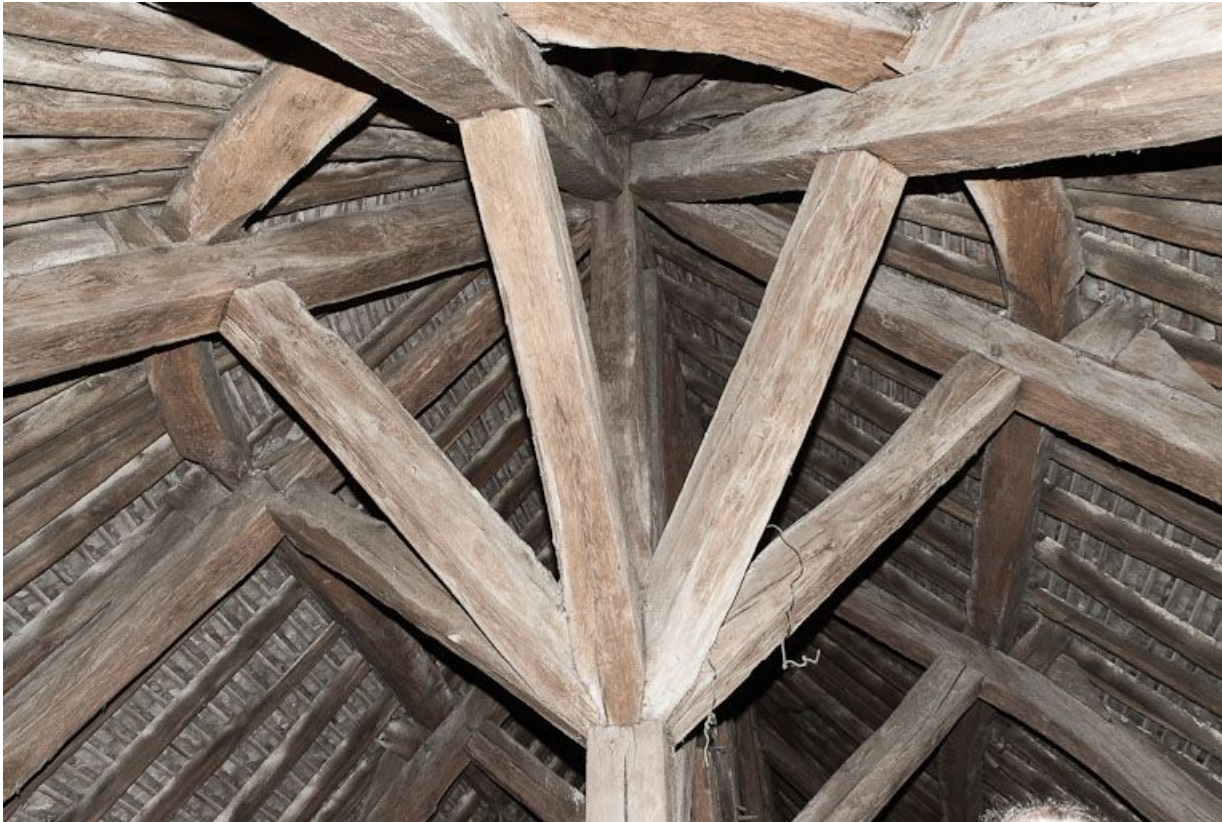
Charpente de croupe de l'abside.
