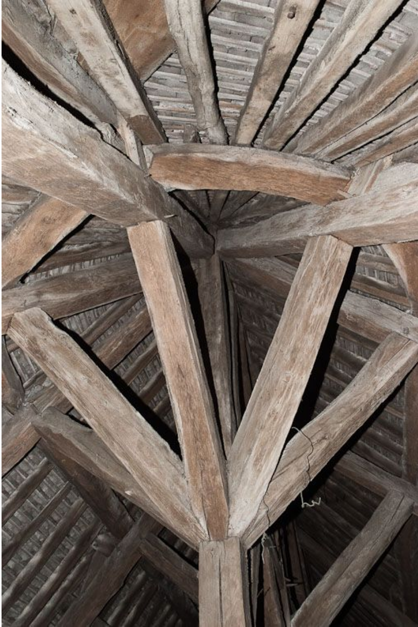
Charpente de croupe de l'abside.
