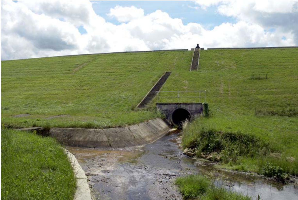
Décharge de fond au centre de la digue principale ; sortie de la digue.
