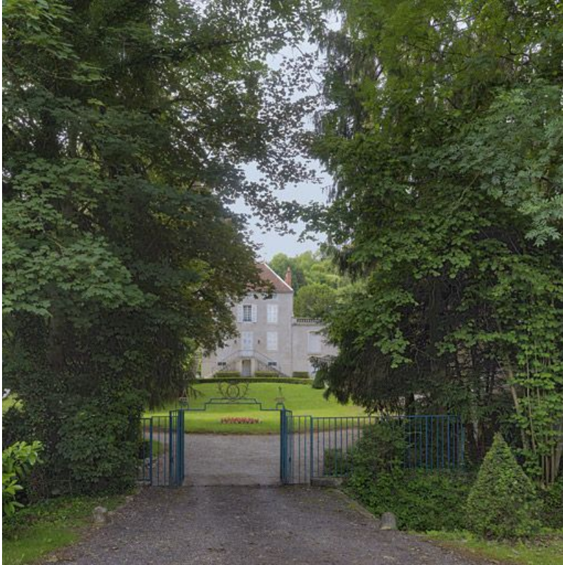
Vue de face du logement patronal de l'usine de Crugey.
