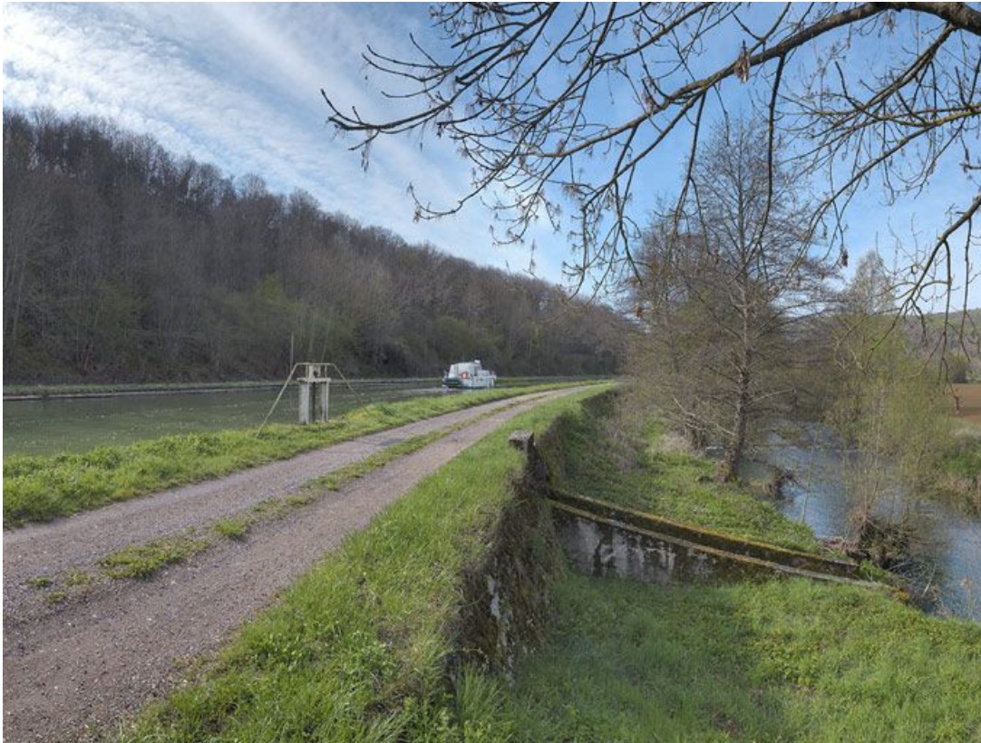
Le déversoir vu du chemin de halage.
