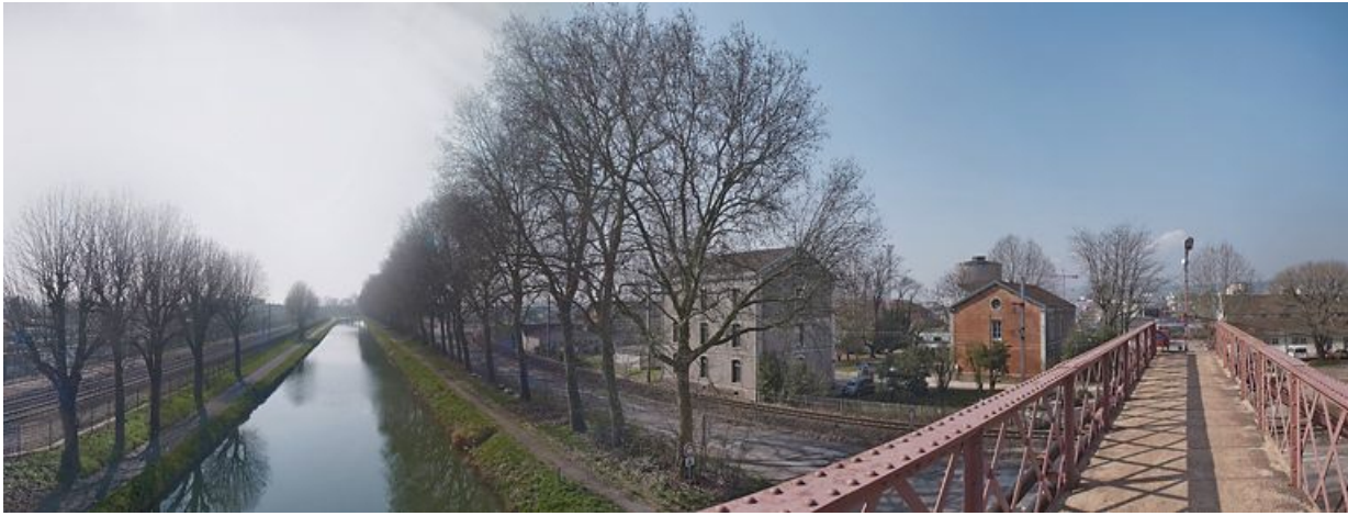
Bureaux du technicentre SNCF.
