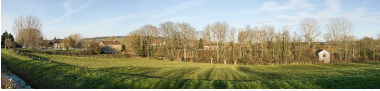
Vue d'ensemble avec en arrière-plan, le port d'Escommes et le site d'écluse 01 du versant Saône. A droite, l'arrière de l'usine hydroélectrique (IA21003655).
