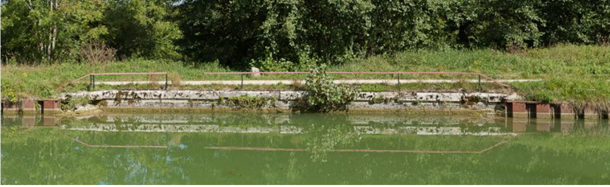
L'arrivée d'eau vue du canal.
