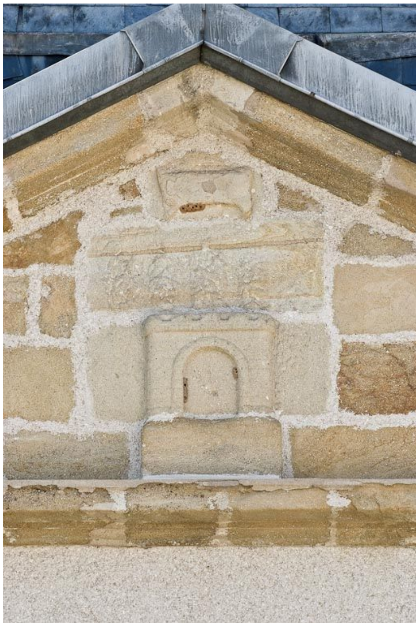
Détail du fronton de la façade.
