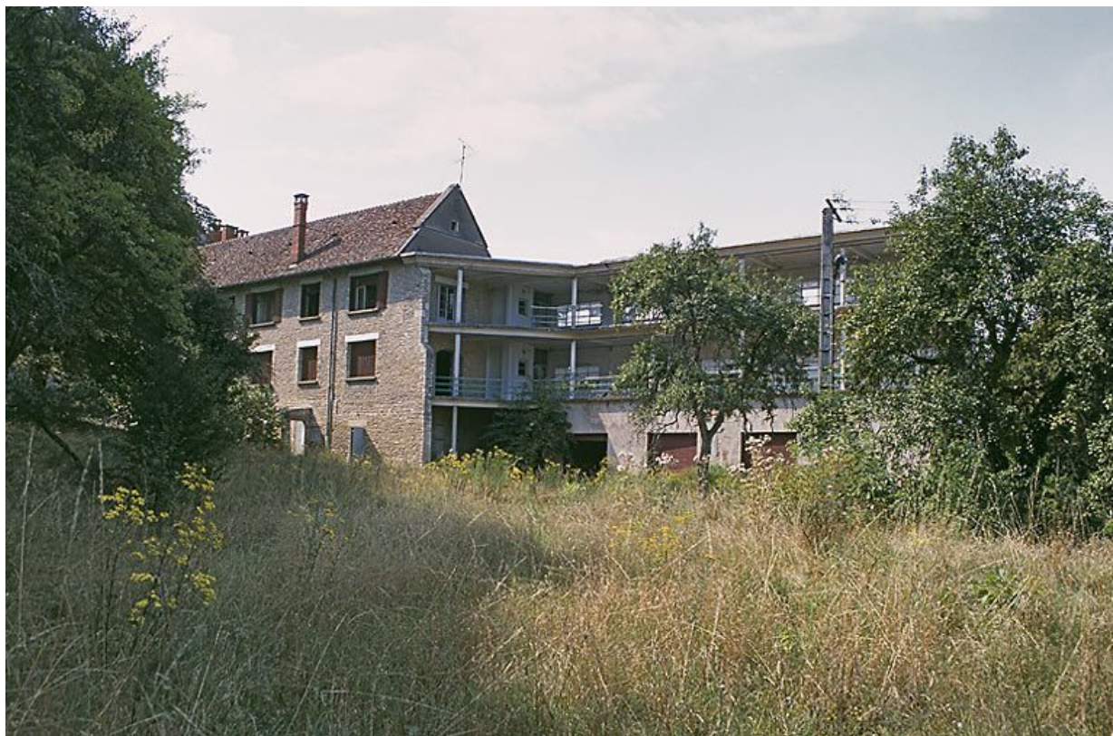
Galerie de cure est, façade sud-est.
