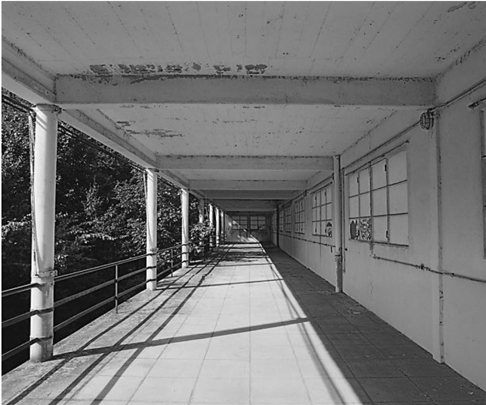
Galerie de cure ouest, façade sud-est.
