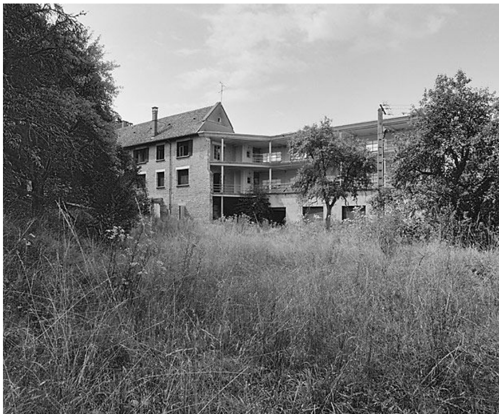
Galerie de cure est, façade sud-est.
