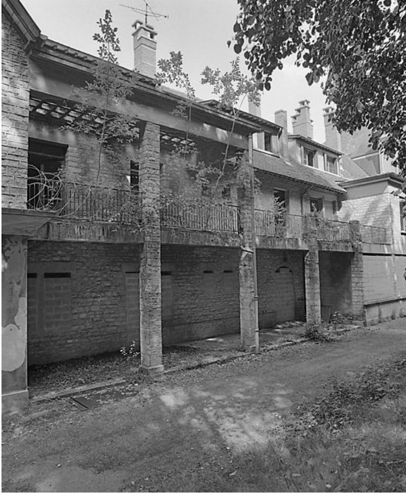
Bâtiment central, façade sud.
