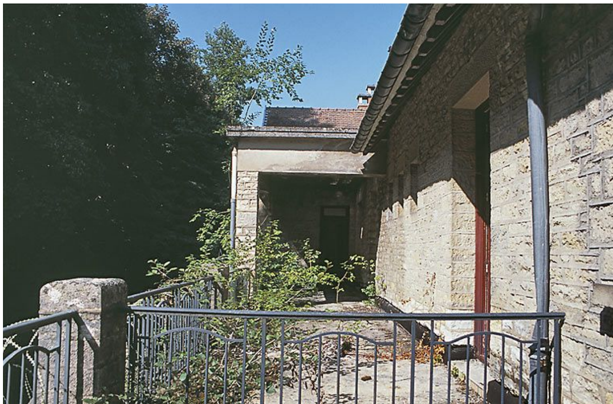
Bâtiment central, terrasses de la façade sud.
