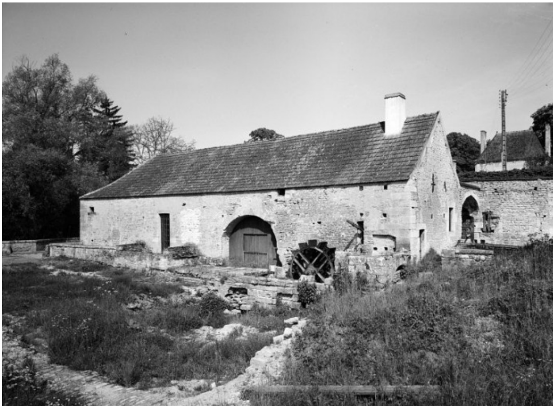
Bâtiment de la fenderie, élévation est.
