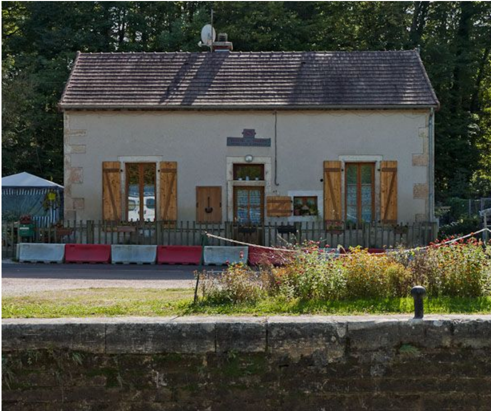
Vue de face de la maison éclusière.
