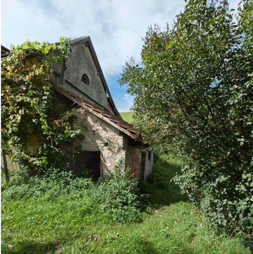
Vue de l'annexe latérale.
