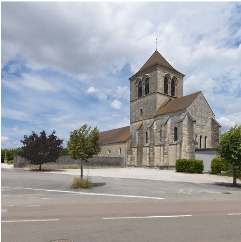
Eglise Saint-Pierre : vue d'ensemble.
