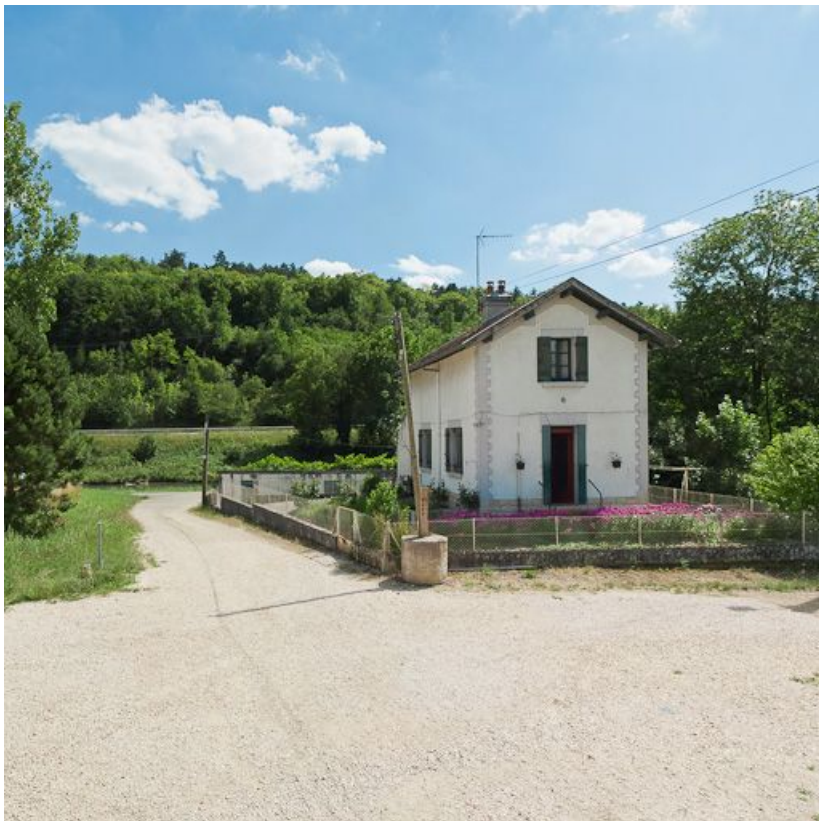
Vue de la maison de garde-barrière.
