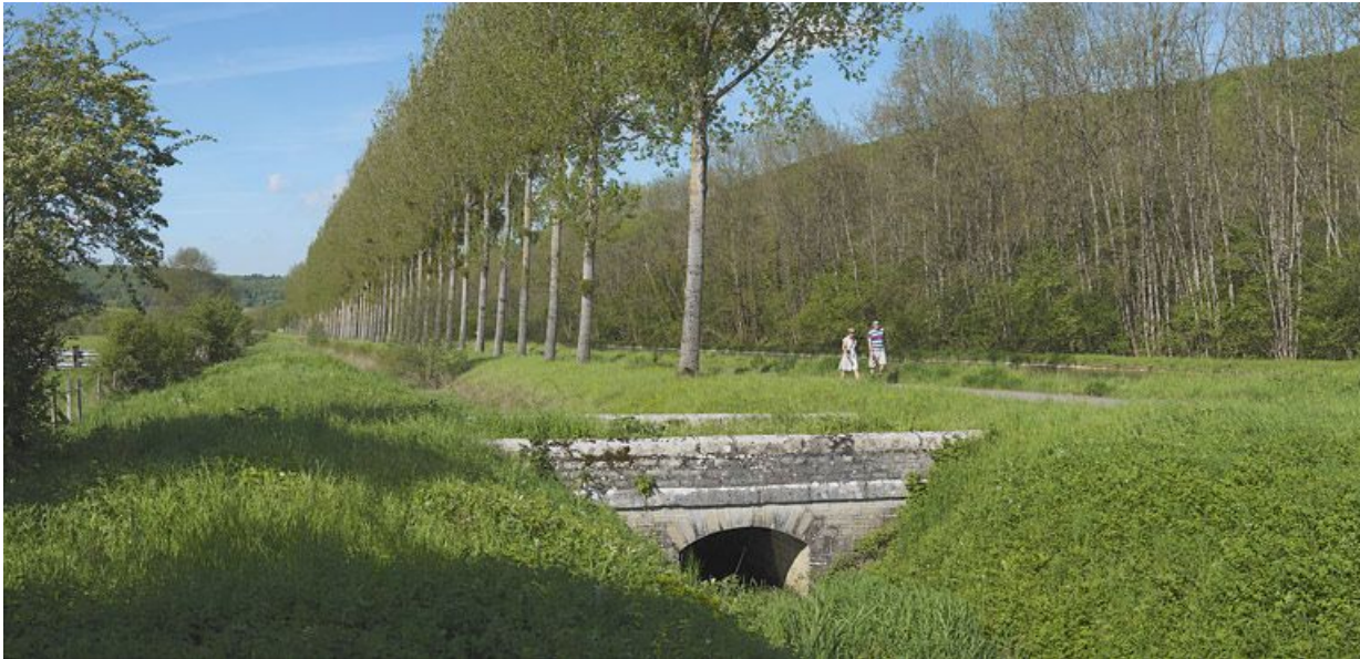
Pont sur rigole rive gauche.
