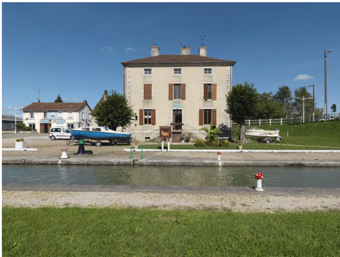
Maison éclusière vue de face.
