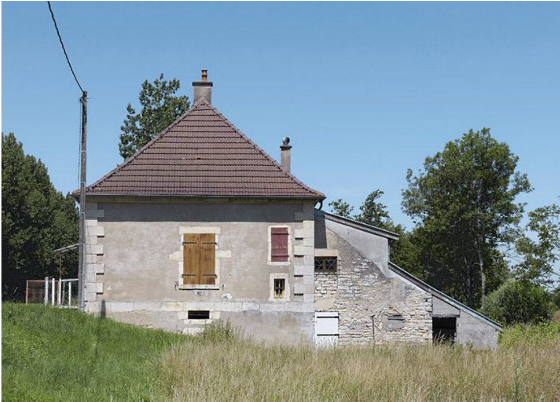
Maison éclusière vue de côté.
