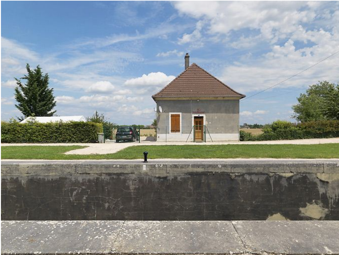
Maison éclusière vue de face.
