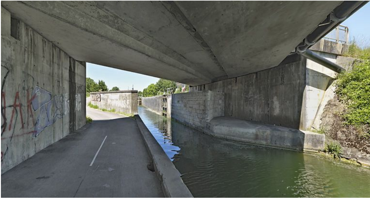
Pont vu d'aval : le sas est ouvert.
