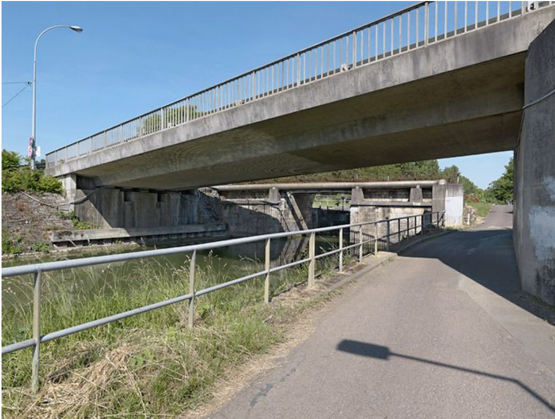
Pont moderne remplaçant le pont sur l'écluse 56.
