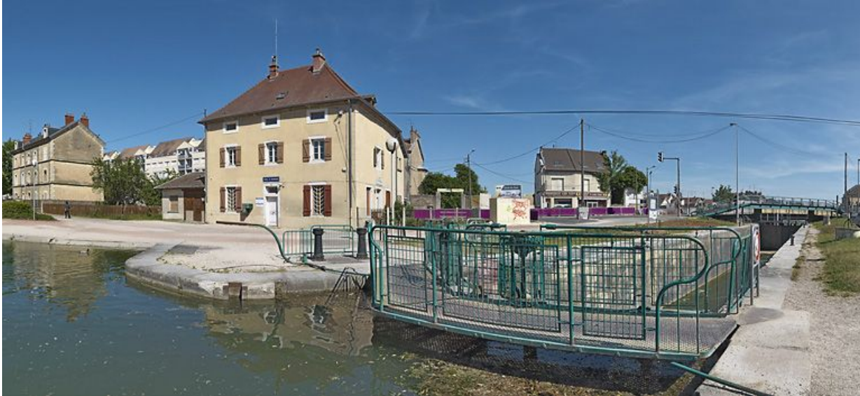
Façade de la maison éclusière donnant sur le port. A droite, le sas. Sur la gauche, on aperçoit la maison de perception. 21, Dijon, lieudit : port du Canal
