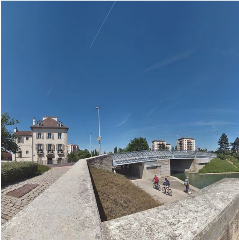
Sur cette vue d'aval du pont, on distingue des restes de l'ancienne maçonnerie des culées. 21, Dijon, lieudit : Port du canal
