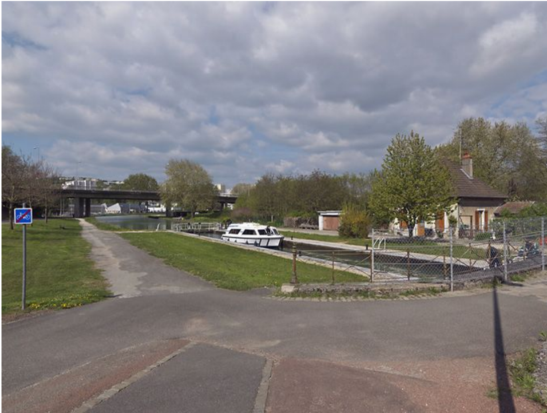
Vue d'ensemble, d'aval.
