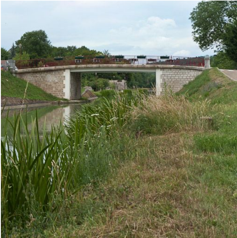
Vue du pont depuis l'aval.
