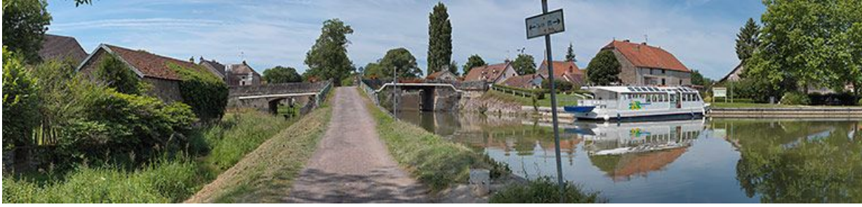
Le pont en moellon et pierre de taille sur la Vandenesse et le pont sur écluse.
