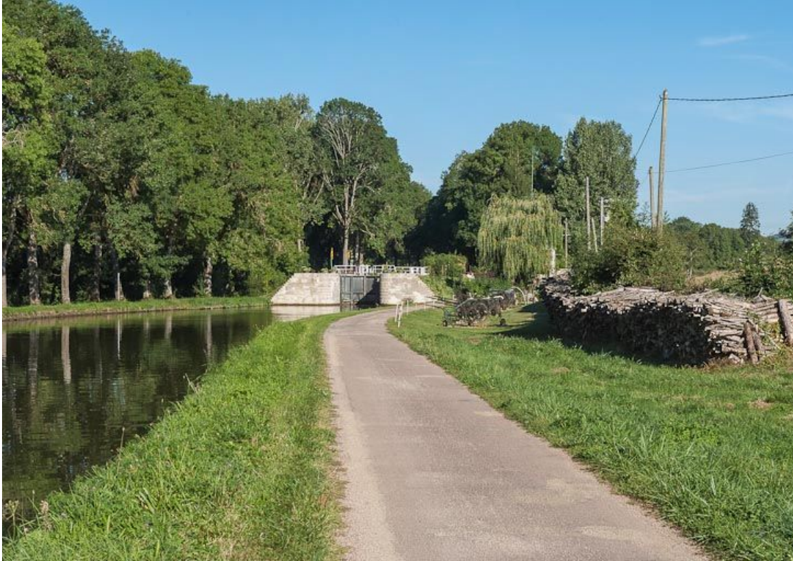
Vue de l'écluse depuis l'aval.
