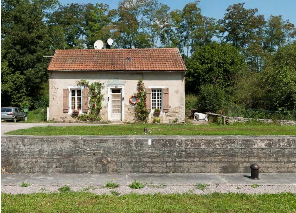
Vue de face de la maison éclusière.
