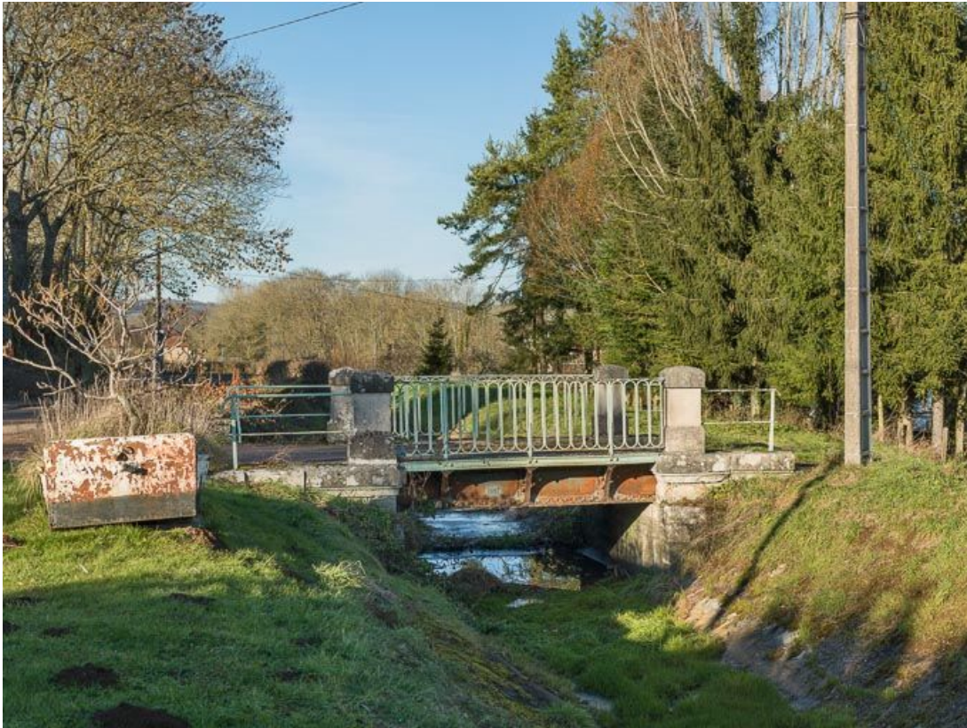
Vue d'ensemble du pont.
